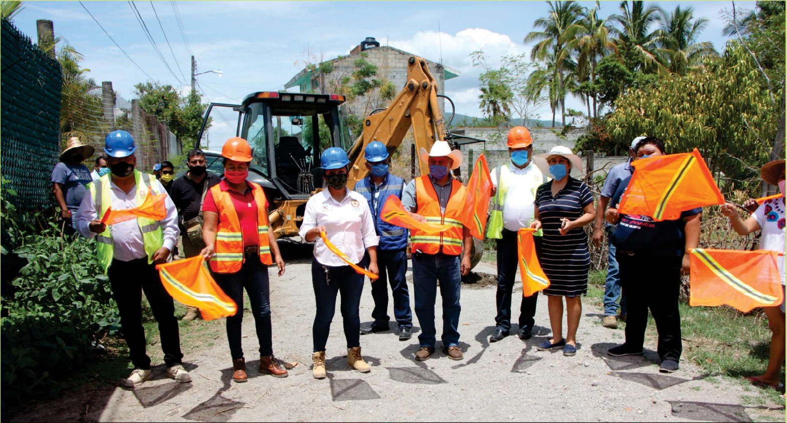
INICIO DE LA CONSTRUCCIÓN DE PAVIMENTACIÓN DE 886.80 METROS CUADRADOS EN LA CALLE JOSÉ MA. MORELOS Y PAVÓN DE LA COL. EMILIANO ZAPATA PARA BENEFICIO DE 250 HABITANTES
